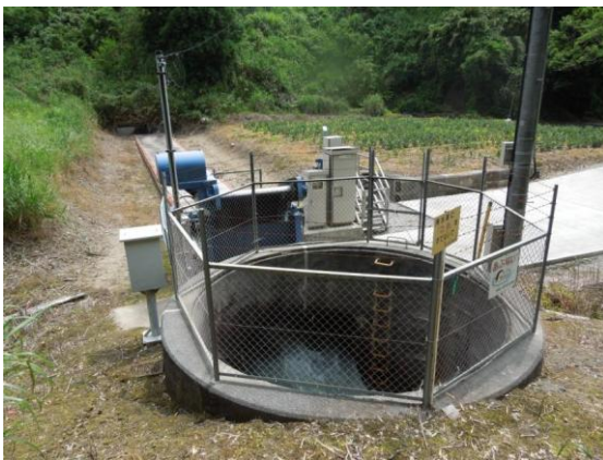
【西方発電所建設予定地（菊川市）】
