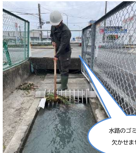
水路ゴミ除去作業➡
