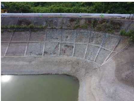
作業状況①
