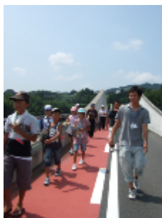
【大井川水路橋(島田市横岡~神座)】
