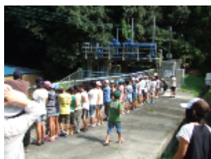
【伊達方分水工(掛川市伊達方)】
