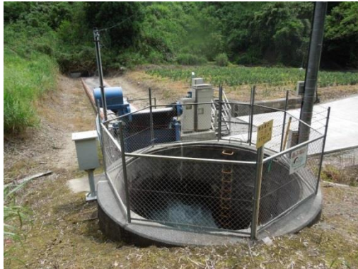
【西方発電所建設予定地（菊川市）】
